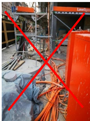
Figure: Source: société Bau-Konzept
