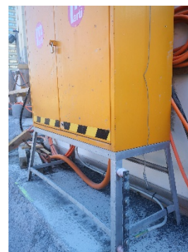
Figure: Source: société Bau-Konzept
