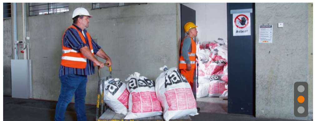
8 Emballage et transport entre chantier et décharge
