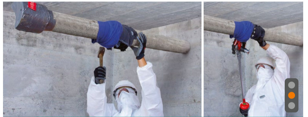
7 Démantèlement minutieux des tuyaux et canalisations contenant de l'amiante
