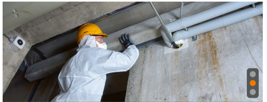
6 Élimination correcte de l'amiante de «niveau orange»
