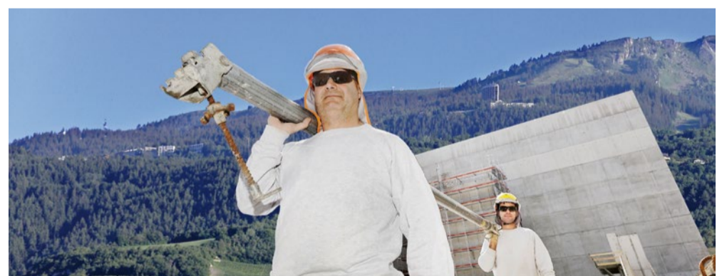
7 Baustellen im Gebirge
