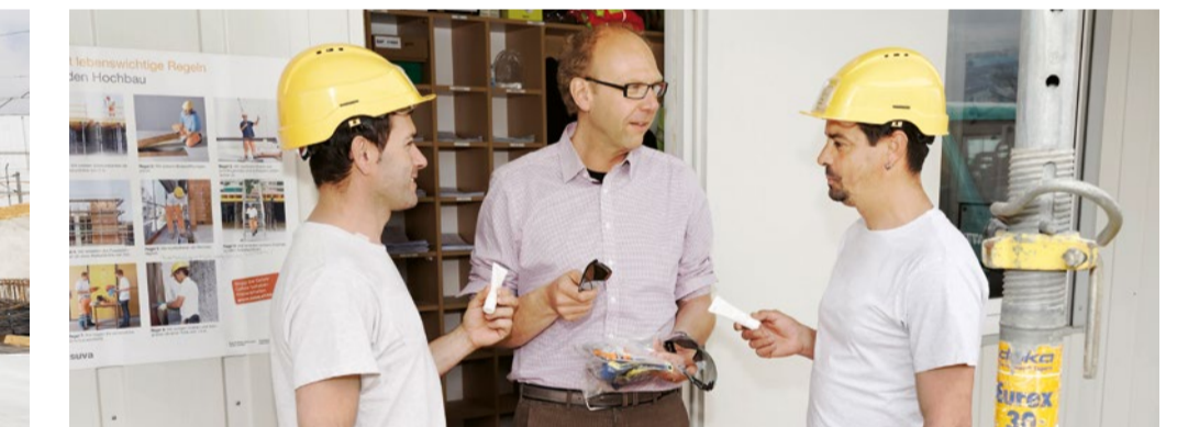
6 Travaux par plus de 30°C
