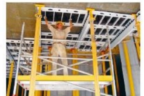
1 Système moderne: coffrage et décoffrage par le bas.
